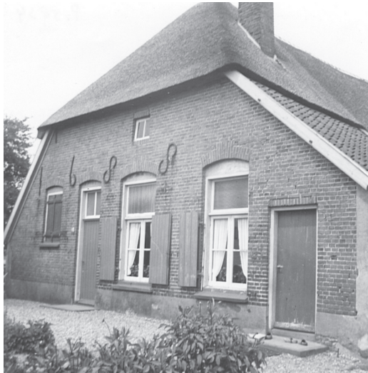
Afb. 3.8 't Lichtje' met muurankers 1688 (foto R. Hardonk, 1955; CODA P-005834)
